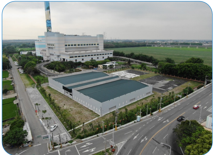
底渣分選廠（多功能倉儲式設施第一期）
