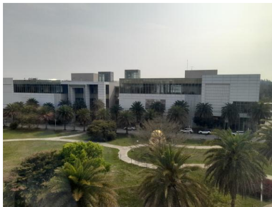
金門工商休閒園區現況
