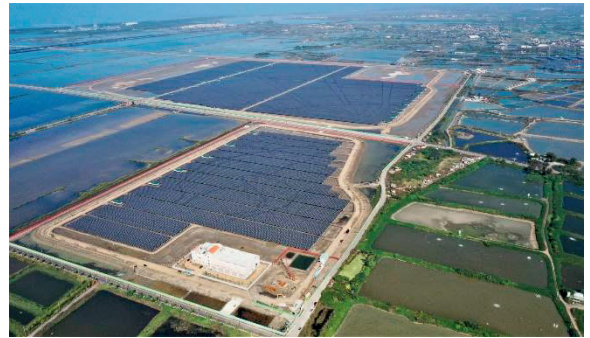
圖 7 臺南鹽田太陽光電場
