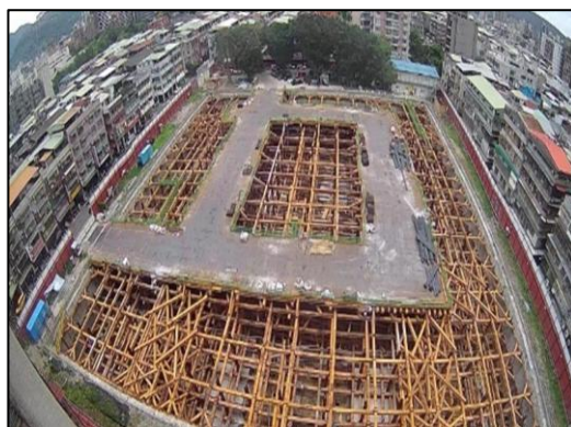
振華公園附建地下停車場新建工程
