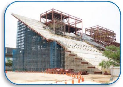
桃園市立美術館施工中外觀
