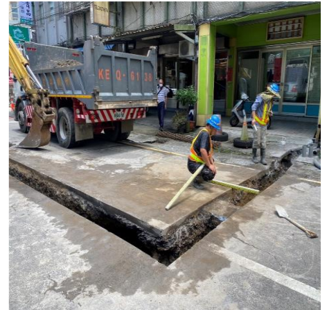
基隆市電纜地下化施作情形
