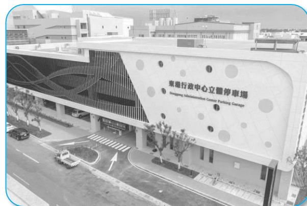
東港行政中心立體停車場
