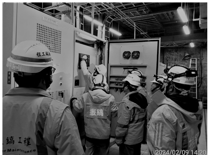
圖 1 113 年 2 月 9 日第一航廈停電事故修復現場
