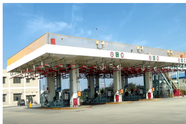
圖9 LNG灌裝設施營運情形
