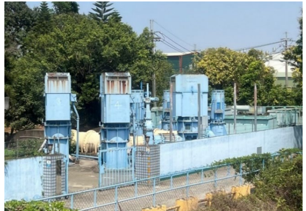
圖 4 離心豎軸式抽水機現況
