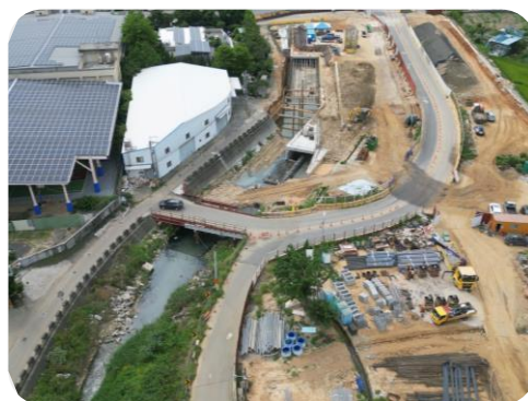
西屯區市政路開闢工程施工情形
