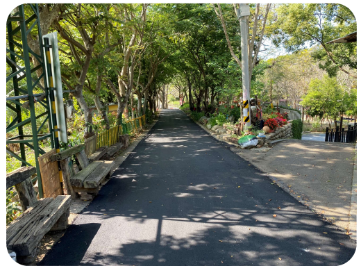
使用焚化再生粒料 后里掩埋場聯外道路
