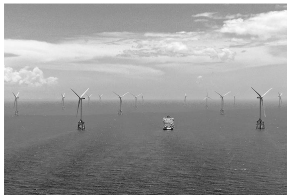
圖 4 台電一期離岸風場
