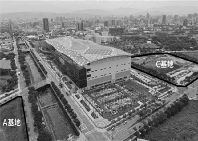
圖 24 臺中水湳國際會展中心西側展館 (A+C 基地) 空照位置
