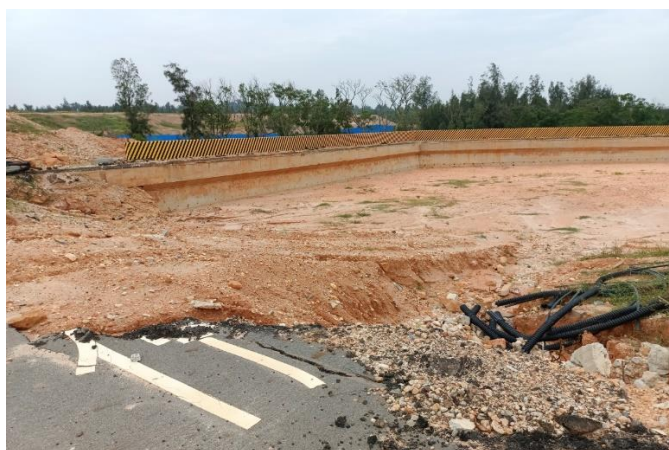
A 區 RD4 道路塌陷區挖除情形
