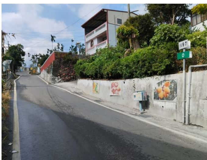
國姓鄉投 81 線 0K+000 處道路舊編號標誌
