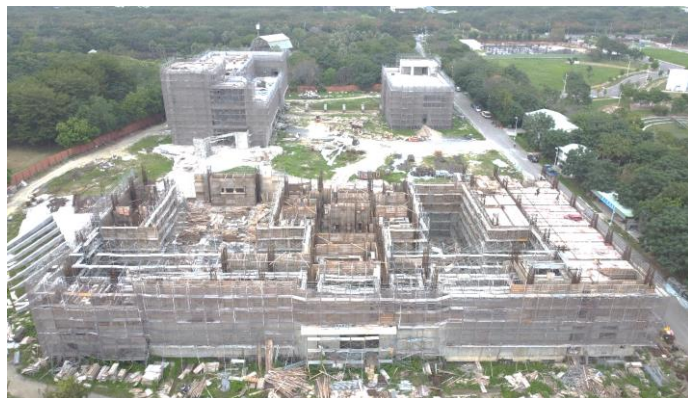
布袋戲傳習中心興建工程施工情形
