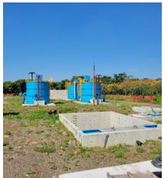
圖 4 屏東縣萬巒淨水場施工情形
