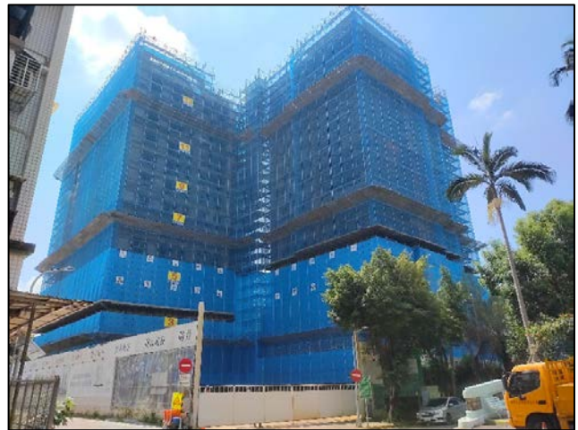
臺北市樟新水岸社會住宅施工情形
