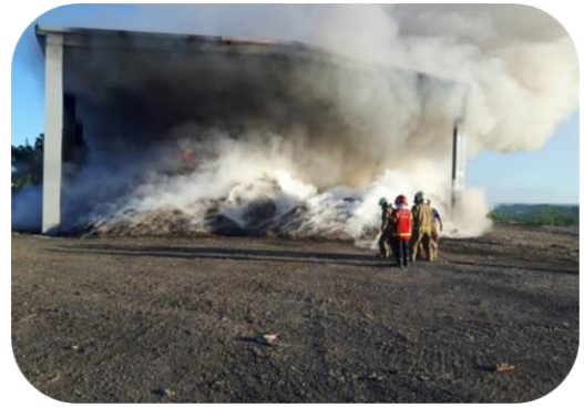
RDF-5 成品貯存鋼棚火災 (圖片來源：臺南市政府環境保護局提供)
