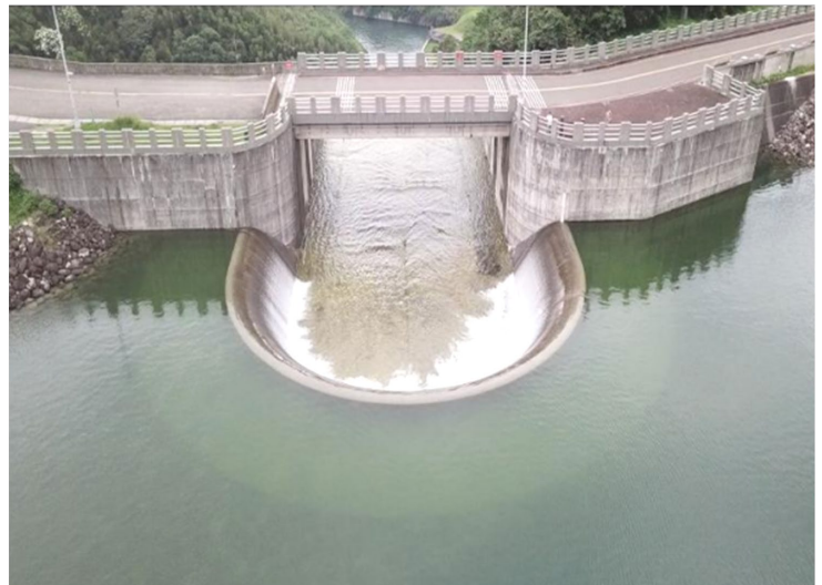
圖 2 寶山水庫第二水庫溢洪道
