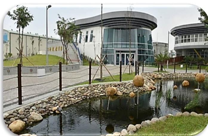
鳳山水資源回收中心
