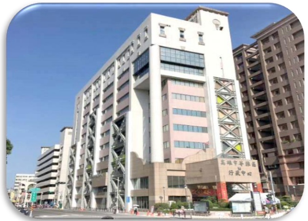
苓雅區行政中心耐震補強完成
