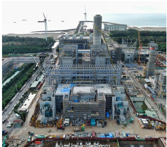
圖3 大潭燃氣機組計畫8號機組施工情形
