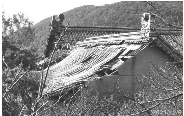
圖 5 國建館東側屋頂外觀
