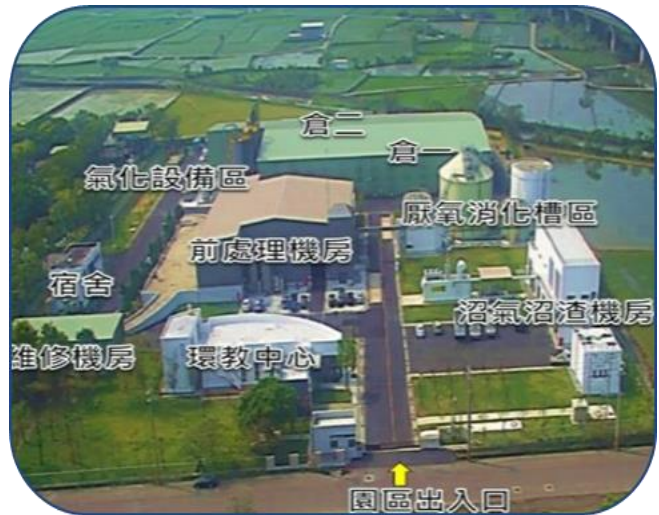
臺中市外埔堆肥廠(綠能生態園區)
