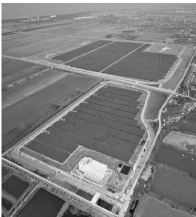
圖 8 臺南將軍及七股區廢棄鹽灘地太陽光電場
