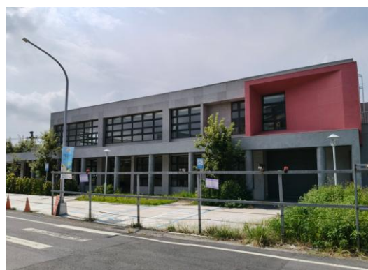
雲林縣崙背鄉衛生所重建工程
