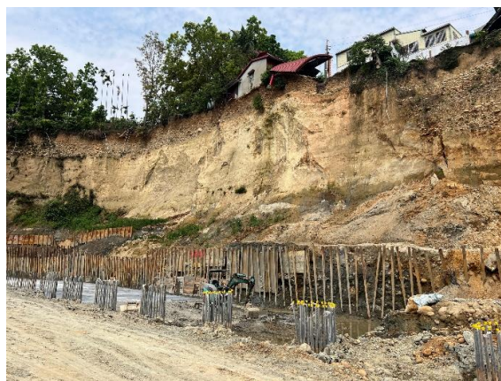
林內鄉坪頂崩塌地整治工程
