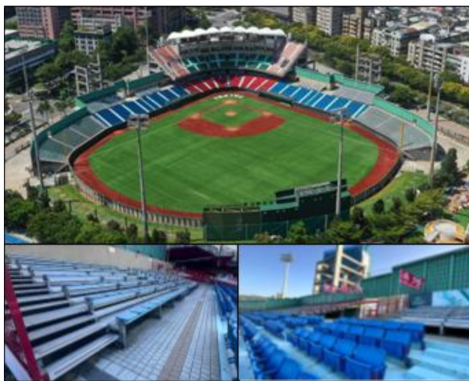
天母棒球場於本工程施工前之全景(上圖)、內野C區2樓鋁製看台(左下圖)、1樓看台(右下圖)
