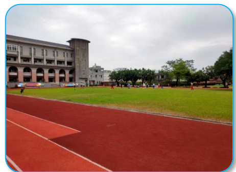
屏東縣萬丹鄉社皮國民小學 操場跑道破損補丁情形
