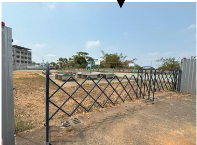
風雨球場施工現況
