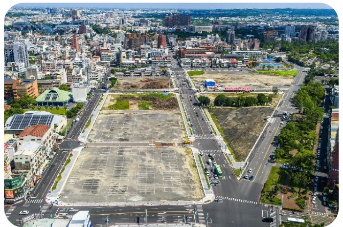
建國二村、復興新村地區市地重劃工程完工現況
