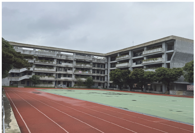
二重國小北棟及東一棟教學大樓現況
