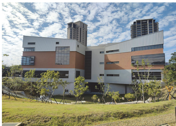
新竹縣立總圖書館新建工程施工現場
