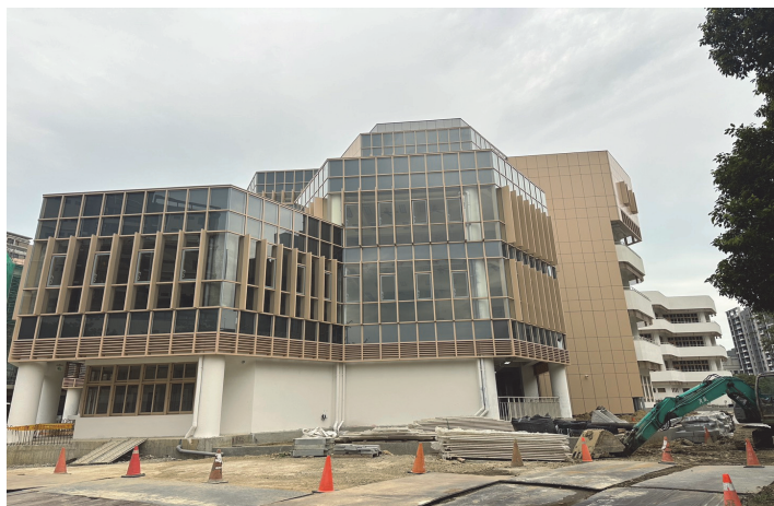
竹北市文小三校舍新建工程施工現場
