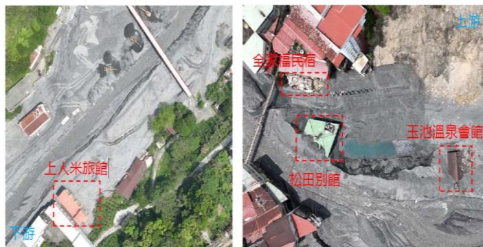
圖 10 廬山塔羅灣溪影響河道及吊橋安全建物拆除工程基地
