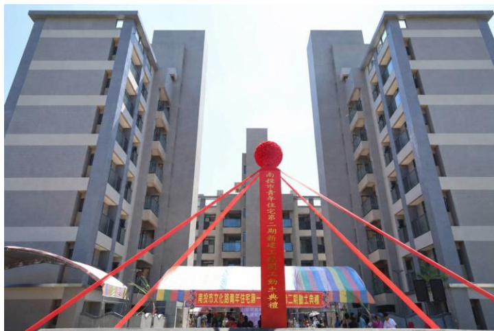
第一期工程落成暨第二期工程動土
