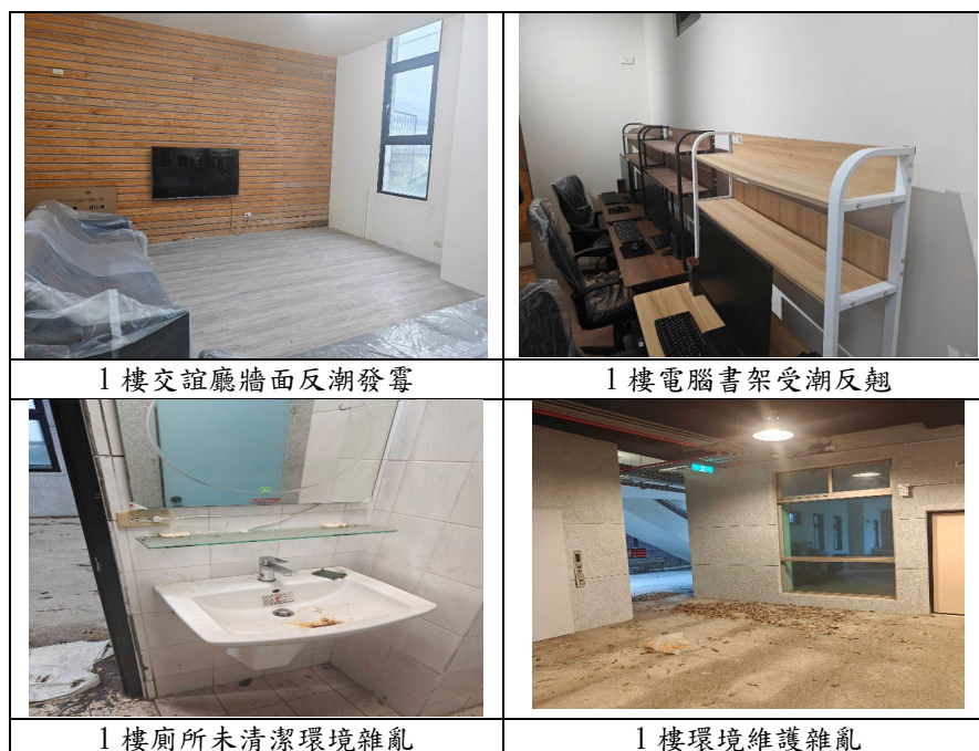
圖 21 多功能會館部分設施及設備使用現況情形
