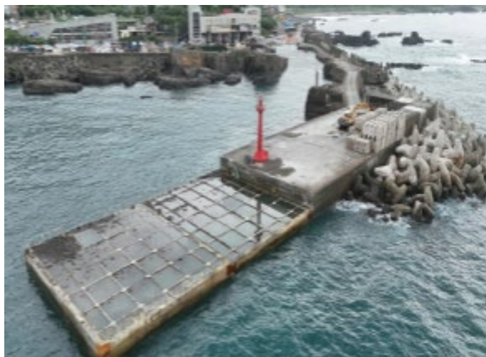
圖 20 大溪漁港東防波堤延長工程沉箱填充情形
