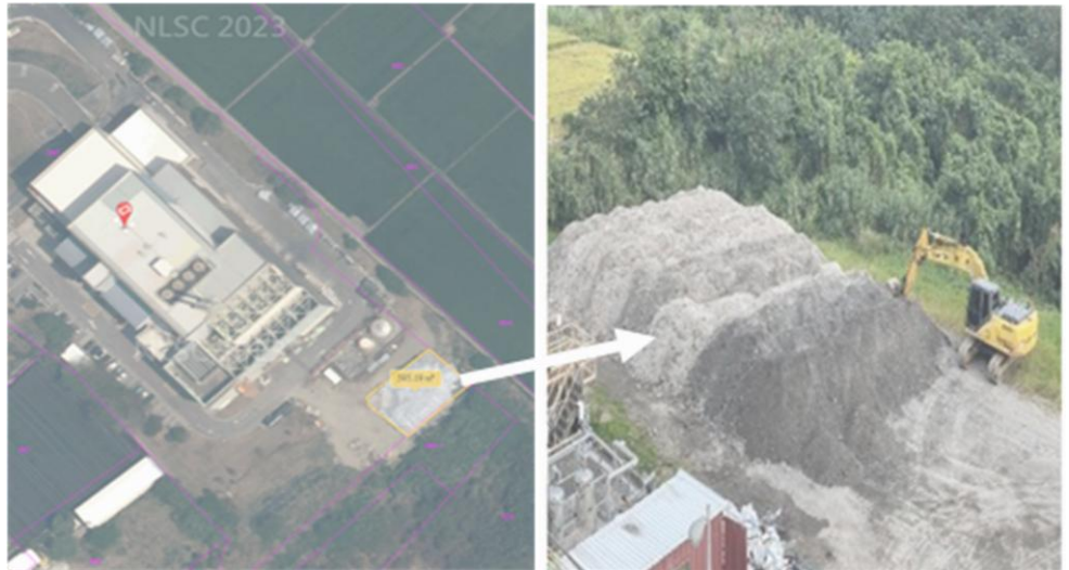
圖2 臺東縣垃圾焚化廠部分植栽綠化區違規作為露天底渣暫置場情形
