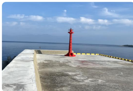
綠島漁港南防波堤堤頭修復工程
