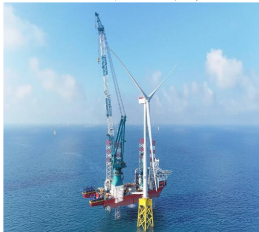
圖 9 離岸風機安裝情形
