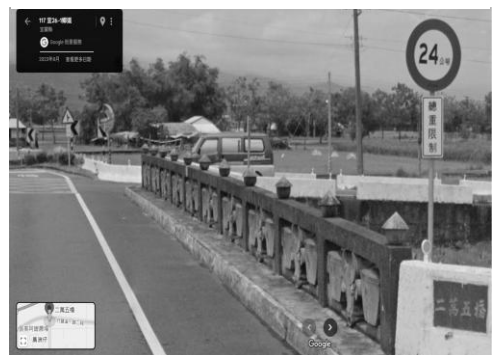
圖 10 橋梁限重告示牌
