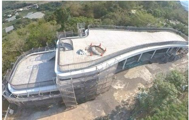
崗山之眼遊憩品質提升工程施工情形
