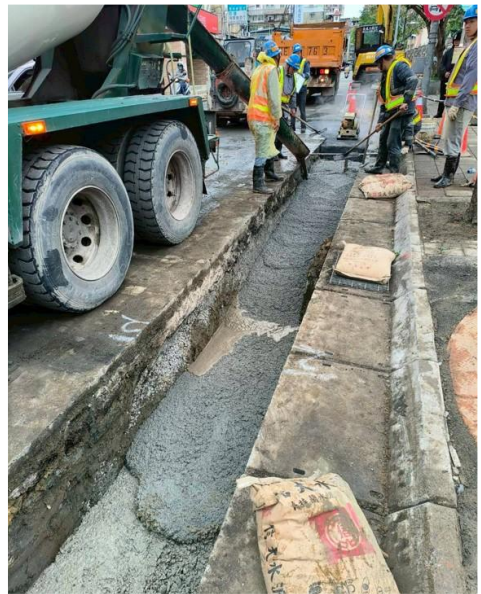
圖 6 焚化再生粒料用於管溝回填
