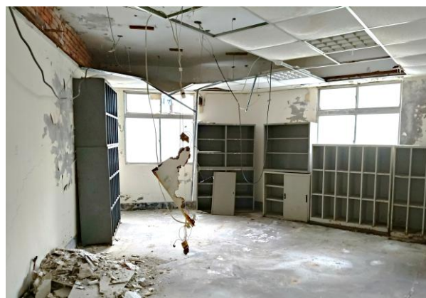
市立醫院急診大樓現況
