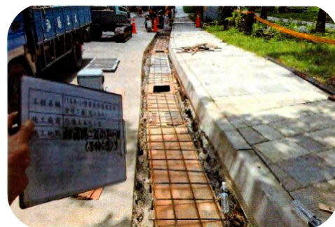
小型零星修復及搶修情形
