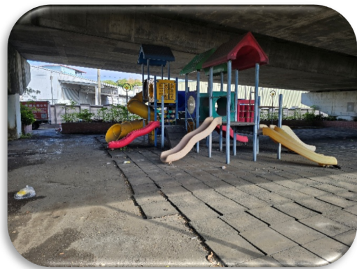
香山陸橋南側橋下空間
