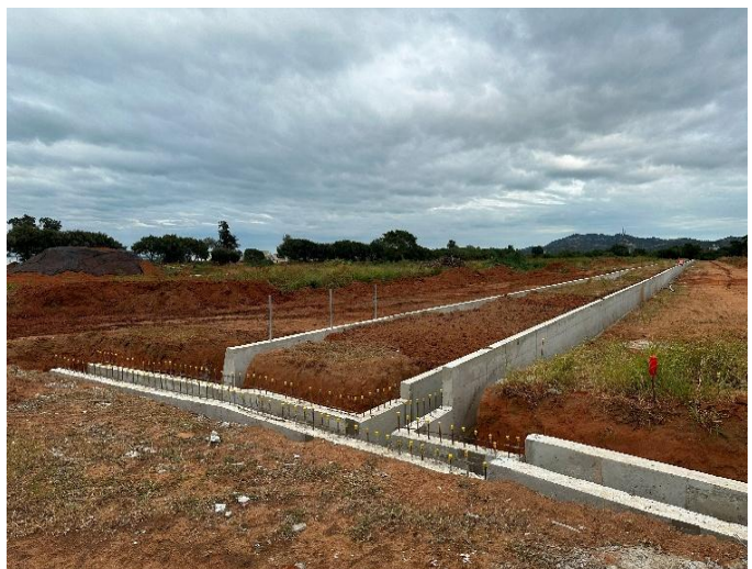
金門縣西山農地重劃區農水路工程—排水路工程
