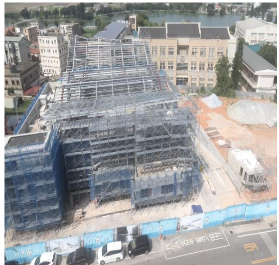
金沙國小地下停車場暨金東 全民運動館興建工程施工現況
