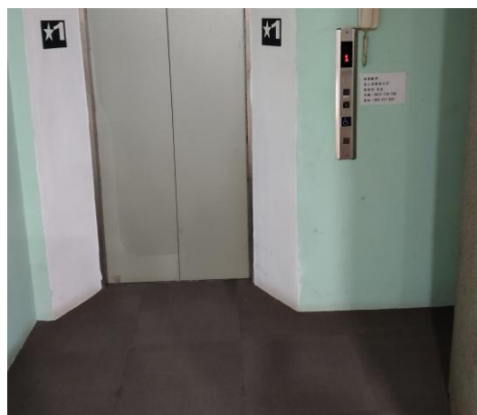
金門縣文化局大樓電梯
