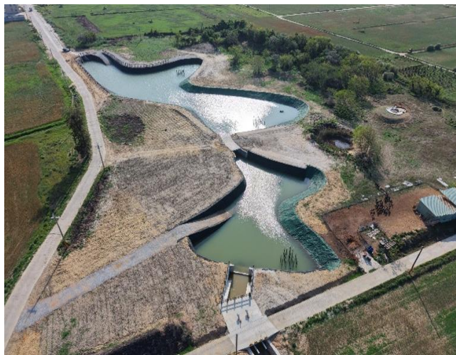
金寧鄉沙崗農場排水分洪截流工程－滯洪池
