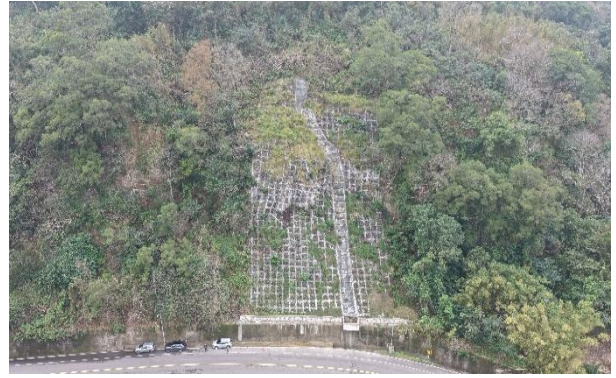
124 乙線 6K+000 段道路復建工程
