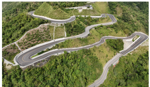
花 64 線 2k+000-22k+500 彎道改善及道路安全提升工程（第二期）空拍
