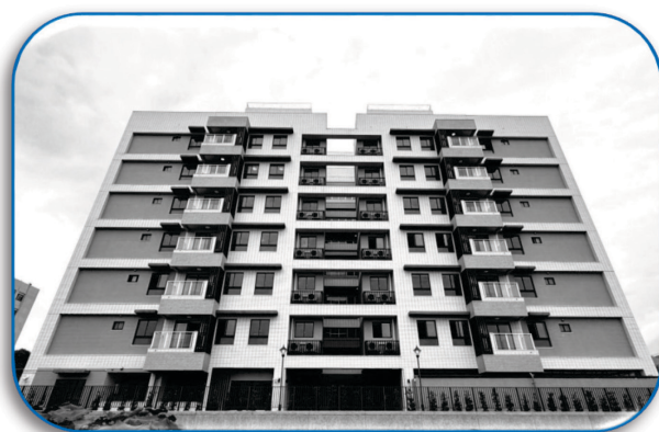
桃園地檢署職務宿舍聯合興建工程
