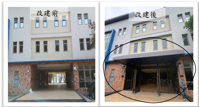
圖 2 阿姆坪水訓基地後門入口及穿堂空間改建情形
