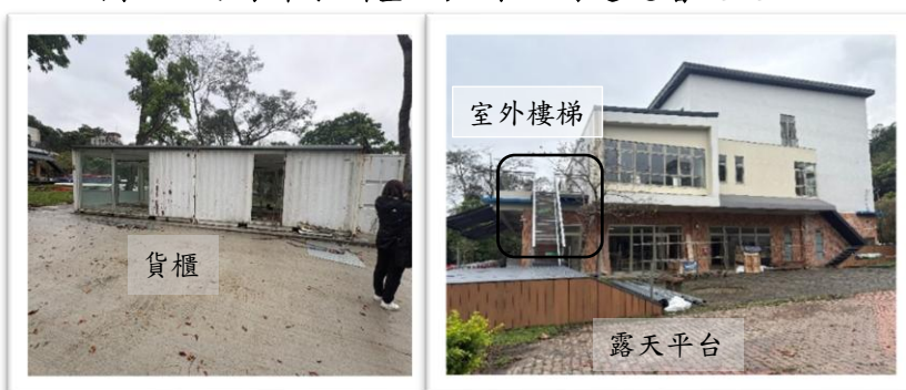
圖 1 阿姆坪水訓基地戶外空間違規增設設施
