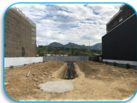
所有權人施作基樁情形
