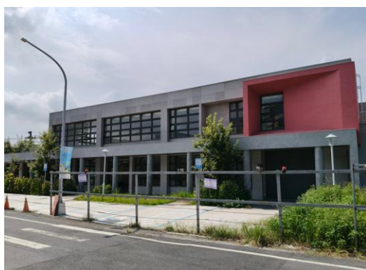
雲林縣崙背鄉衛生所重建工程
