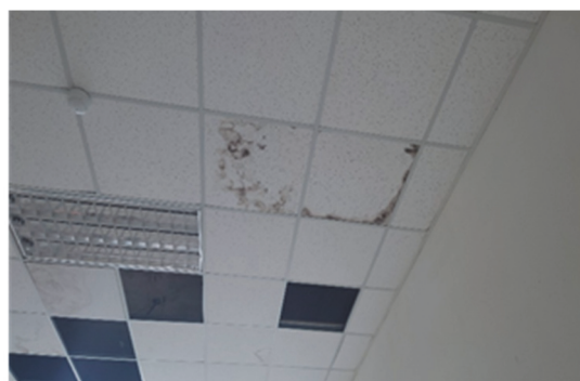
屋頂漏水導致教室天花板腐蝕掉落
