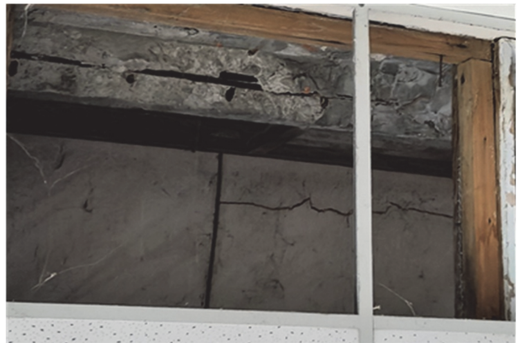
新埔國小中正堂 2 樓結構體鋼筋裸露鏽蝕
