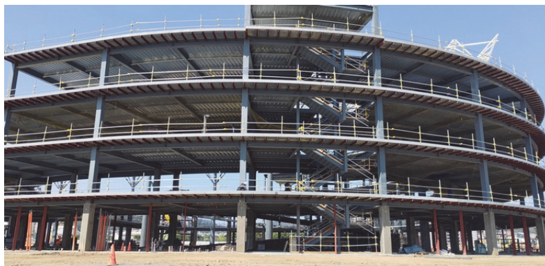
竹東文化大禾埕已完成 4 樓建築鋼骨結構
