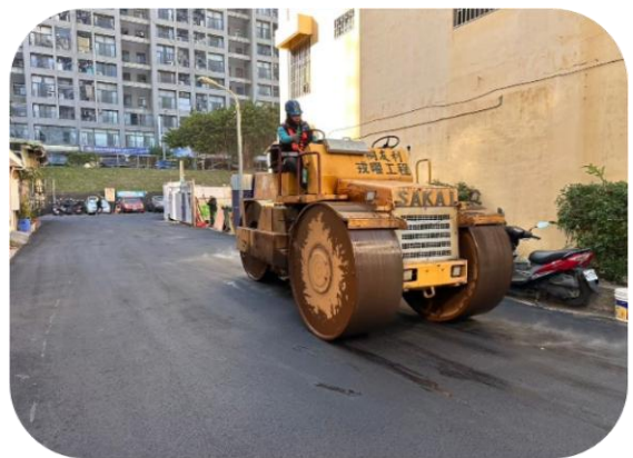
瀝青混凝土面層鋪設情形
