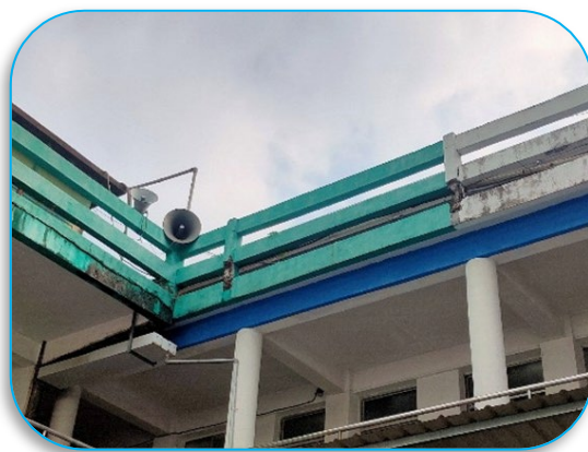
屏東市歸來國民小學南棟校舍 屋頂女兒牆外牆損壞情形
