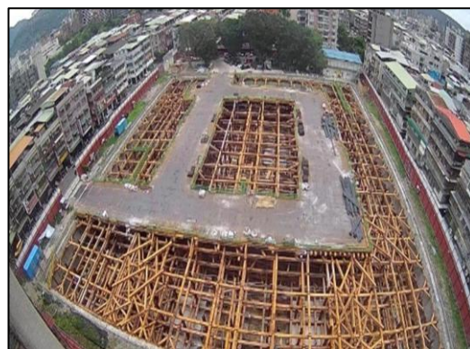
振華公園附建地下停車場新建工程
